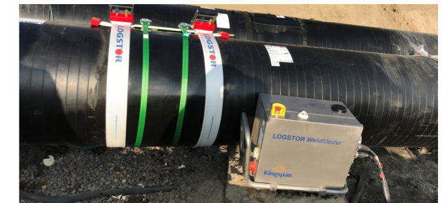
LOGSTOR WeldMaster mit zwei Schweißaggregaten. PDA/LOGSTOR Connect zur Fernsteuerung des Schweißprozesses. Der 2D-Barcode auf der Verbindung enthält die notwendigen Daten für den Schweißprozess und wird mit dem PDA/LOGSTOR Connect gescannt.
