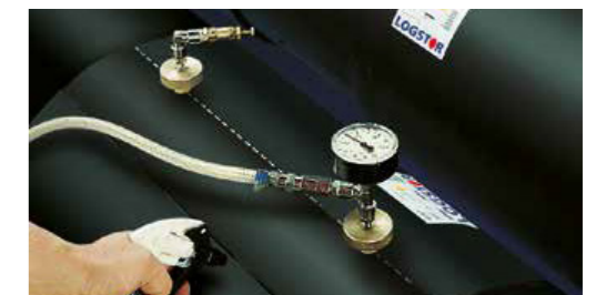
Dichtheitsprüfung vor dem Schäumen.
