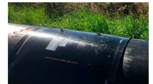
Der Barcode enthält eindeutige Daten über die Art und Abmessung der Verbindung sowie die Widerstandsfähigkeit der Schweißdrähte.
